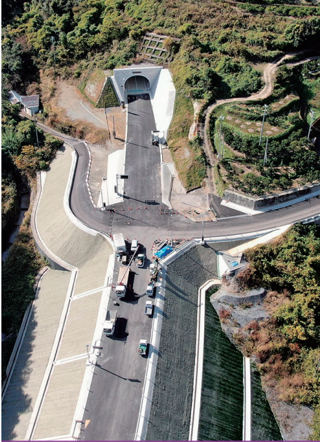
新たに開通する「鏡石トンネル」の海南側 入口付近(写真提供＝県海南工事事務所)
